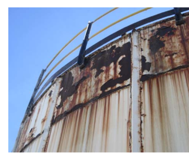
REFORMA DE LA BARANDILLA
