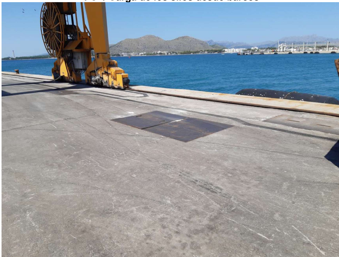
Registro donde se instala la conexión para la carga de los silos
