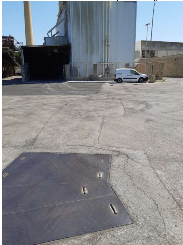
Recorrido subterráneo del tubo de carga desde el muelle hasta el silo
