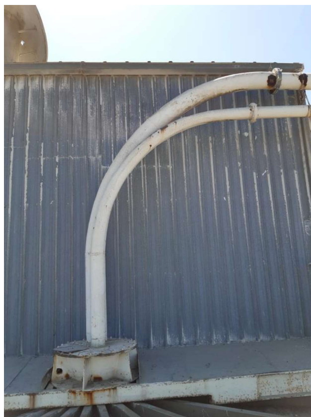
Entrada del tubo de carga a cada uno de los silos
